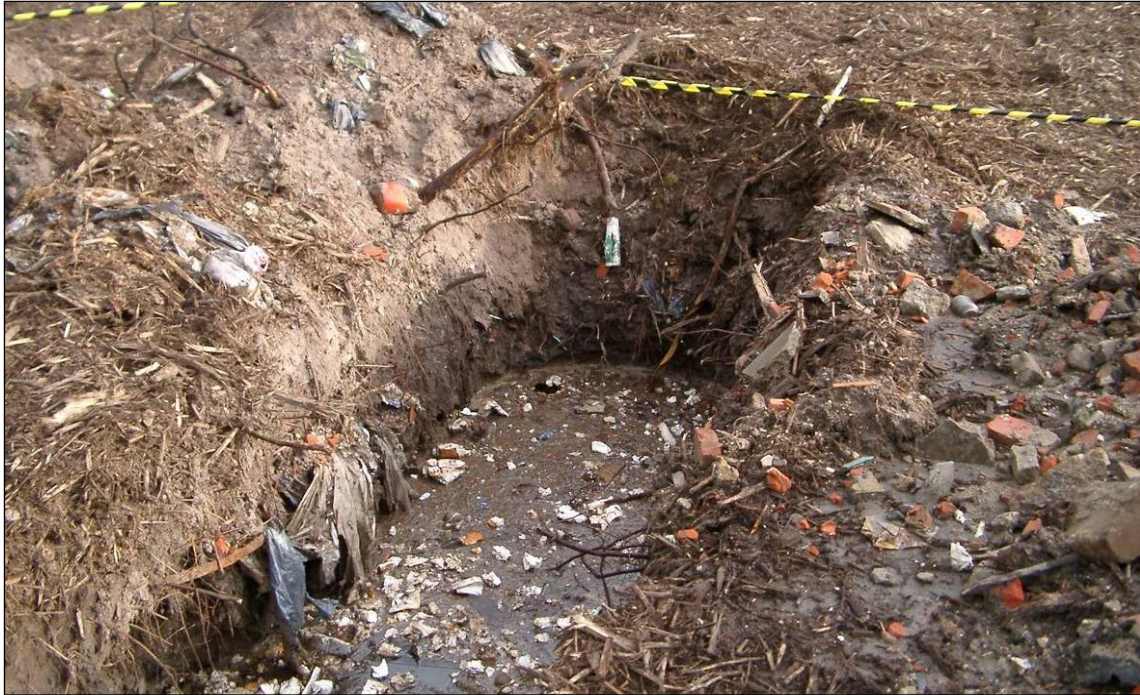
Foto 3 – Garbic Urbic Technosol (Toxic): huishoudelijk afval, bouwpuin en giftig afval (o.a. creosoot olie en zware metalen) op een voormalig stort (Turnhout, Antwerpen) [nota: intussen is de site gesaneerd]
